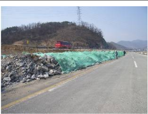
폐콘크리트 덮개 설치
